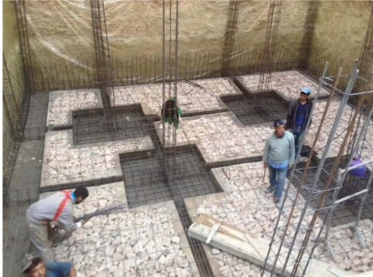
Figure 1-2 : Fondation superficielle d'un bâtiment.
